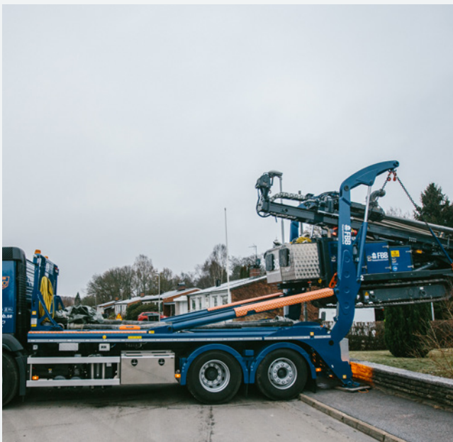
Inlyftning av borrhigg över mur.
