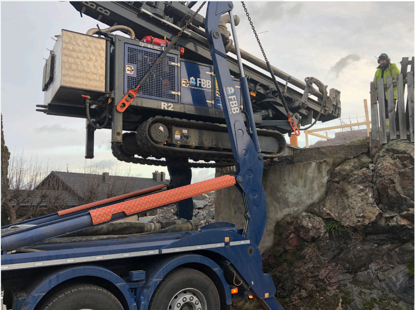
Inlyftning av borrhigg vid svåråtkomlig terräng.
