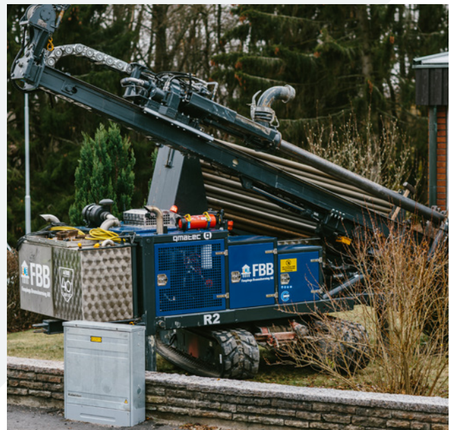
Borring för geoenergi/bergvärme vid kompakta ytor.
